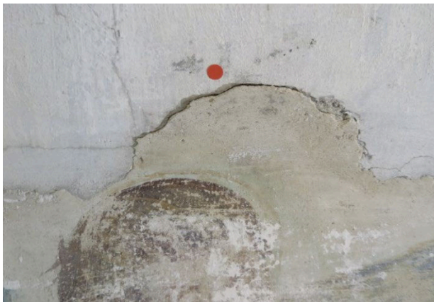
Fig. 16. Nordvæg, opskallet malepuds i toppen af maleriet.
