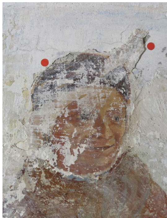
Fig. 19. Sydvestvæg, opskallet malepuds.
