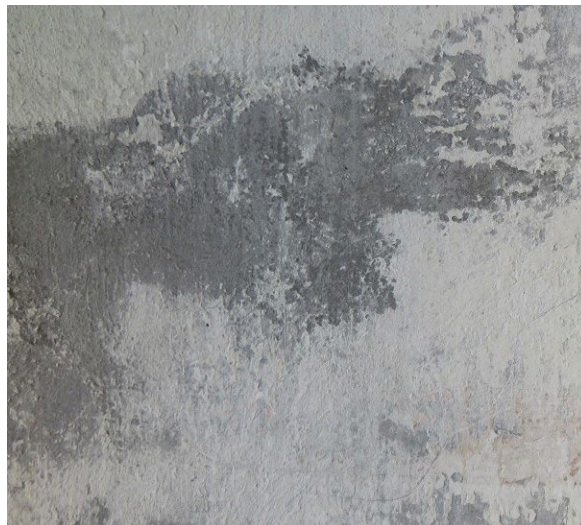
Fig. 4. Overflade på fint cementpudsning.
