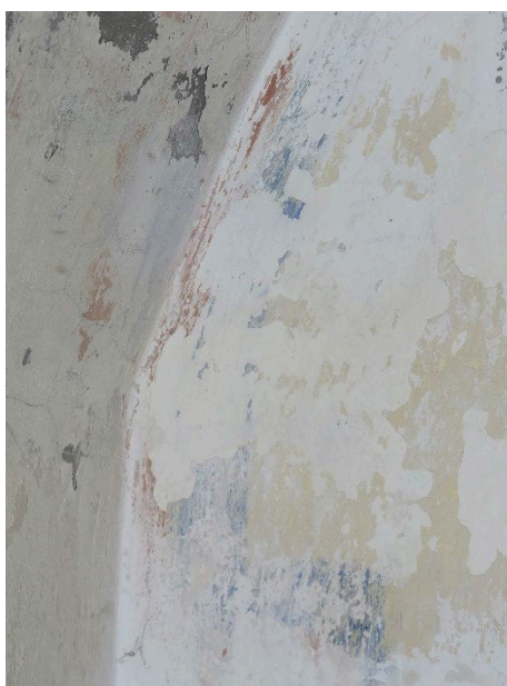
Fig. 7. Vestvæg, bånd langs tøndehvælv.
