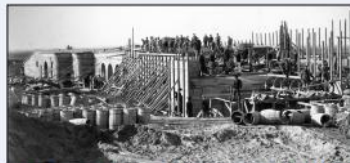
Fortunefortet. Støbningen af betongasematten, 28. februar 1892.
