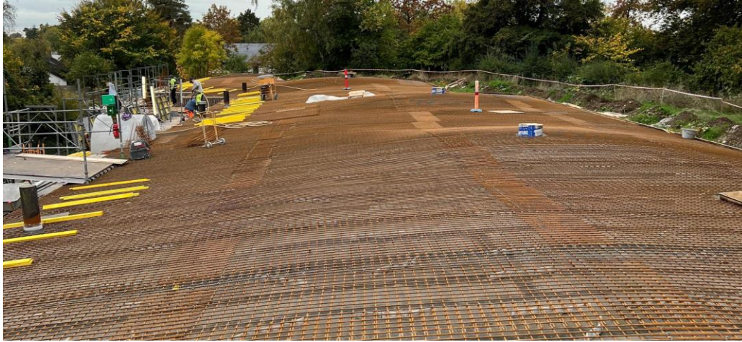
Taget med armering, klar til støbning
