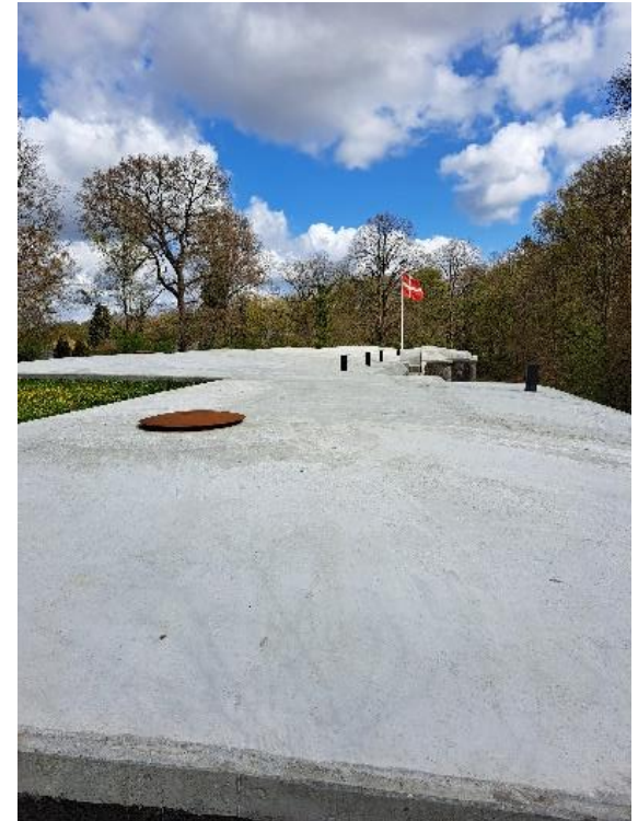
Det færdigstøbte betontag
