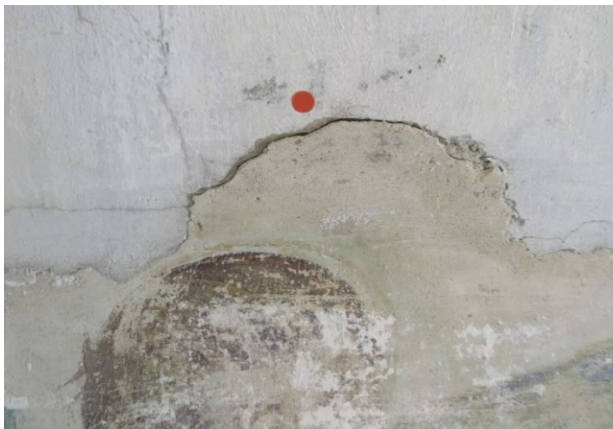
Fig. 16. Nordvæg, opskallet malepuds i toppen af maleriet.
