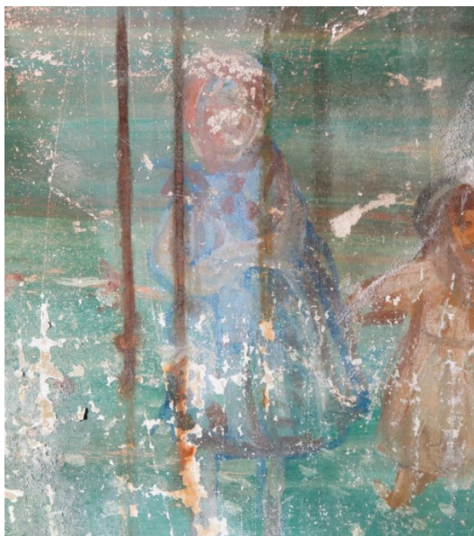
Fig. 26. Sydvestvæg, løbere af rust ned over farvelaget. Fig. 27. Sydvestvæg, mekanisk slid i farvelaget.
