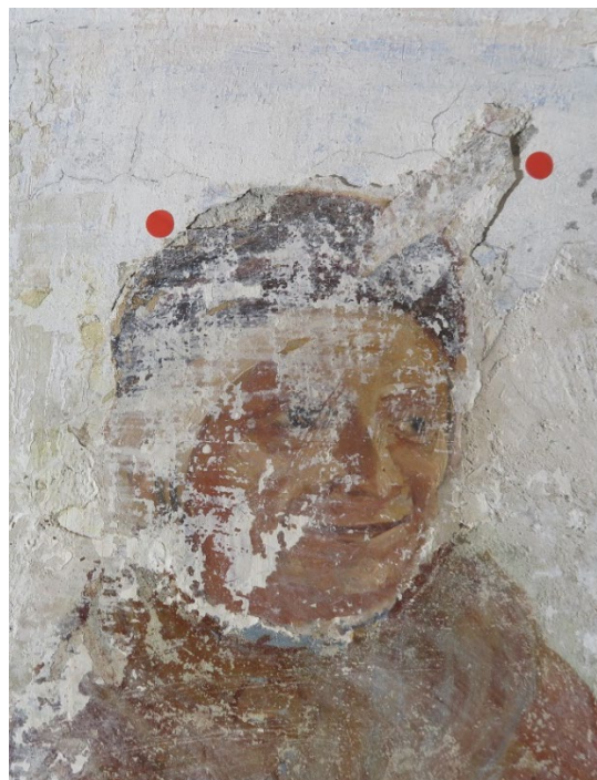
Fig. 19. Sydvestvæg, opskallet malepuds.
