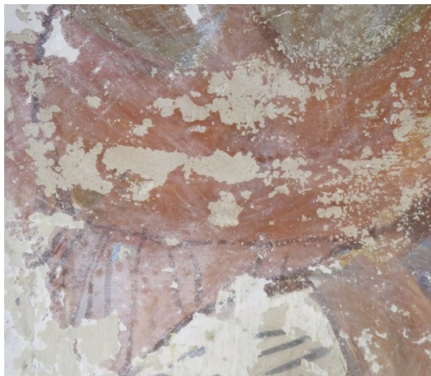
Fig. 21. Sydvestvæg, afskalning af farvelag.
