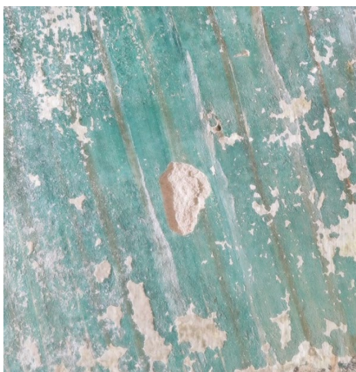
Fig. 20. Sydvestvæg, afskalning af farvelag ind i puds.
