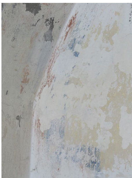
Fig. 7. Vestvæg, bånd langs tøndehvælv.
