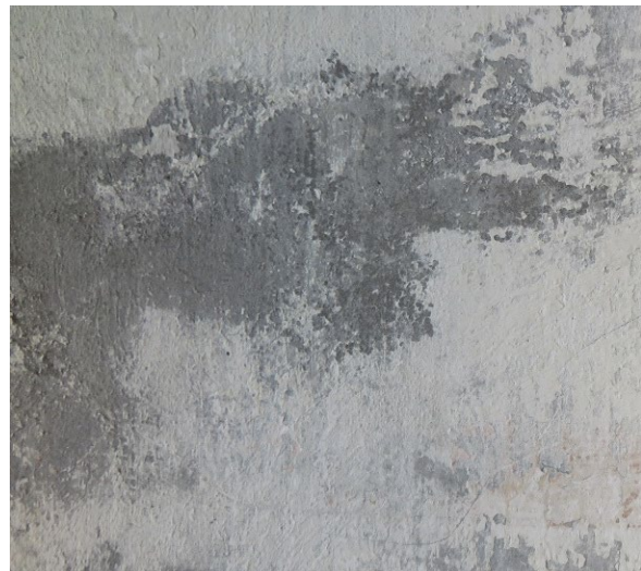
Fig. 4. Overflade på fint cementpudsning.
