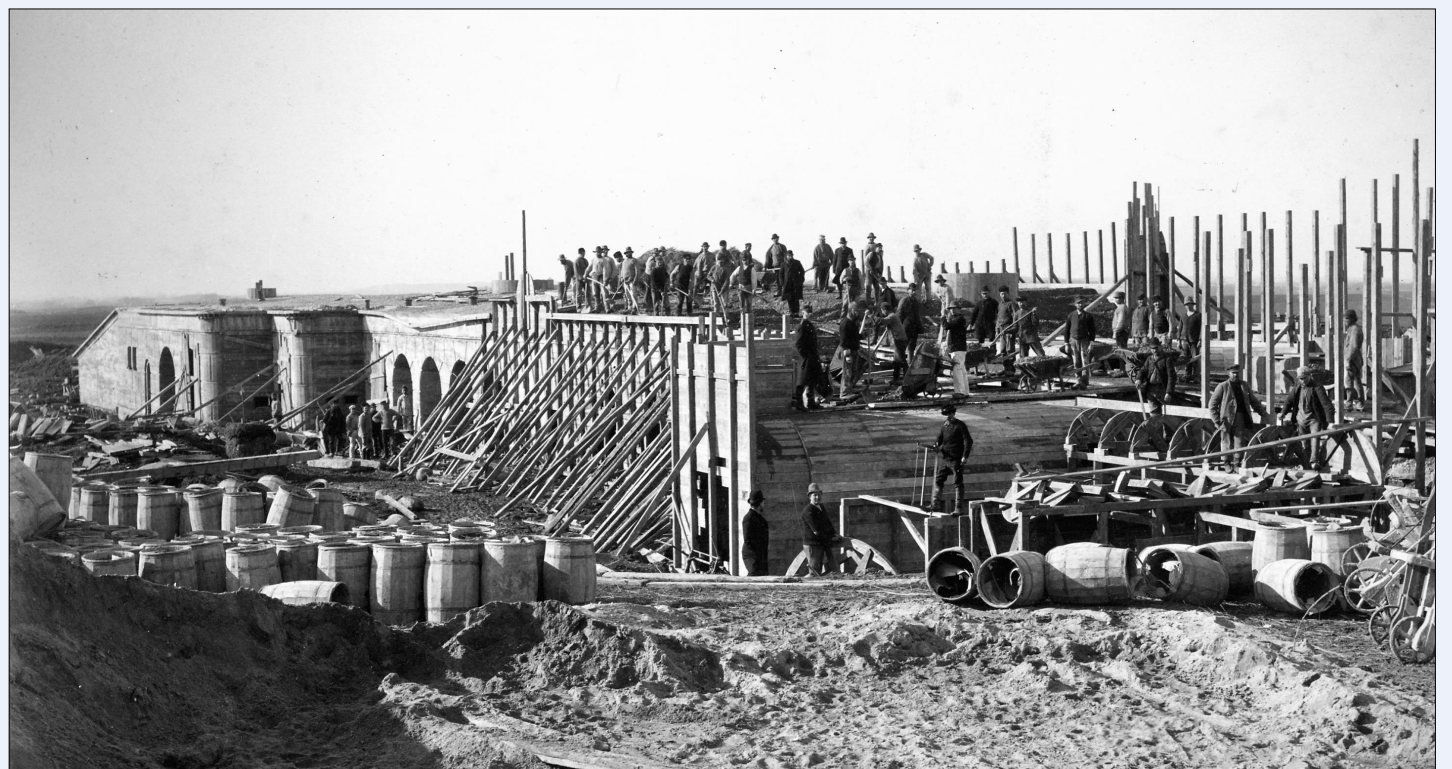
Fortunfortet. Støbningen af den nordøstlige del af betonkasematten, 28. februar 1892.
