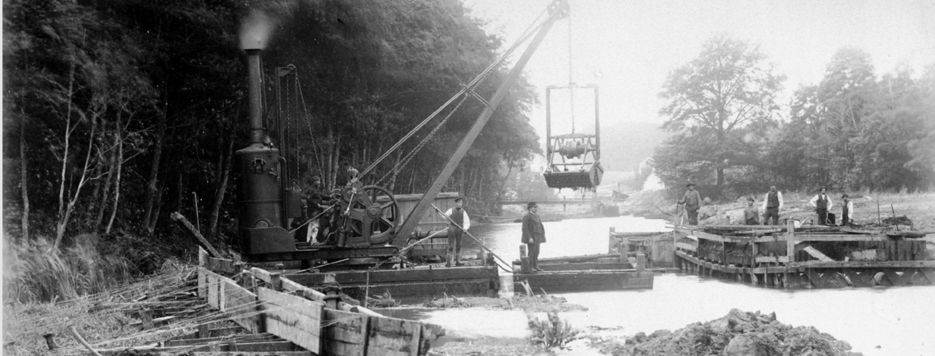
/ Udgravning i Mølleåen, der mellem Furesø og Lyngby Sø blev rettet ud og lagt i en kanal, i efteråret 1887. Foto: Nationalmuseet
