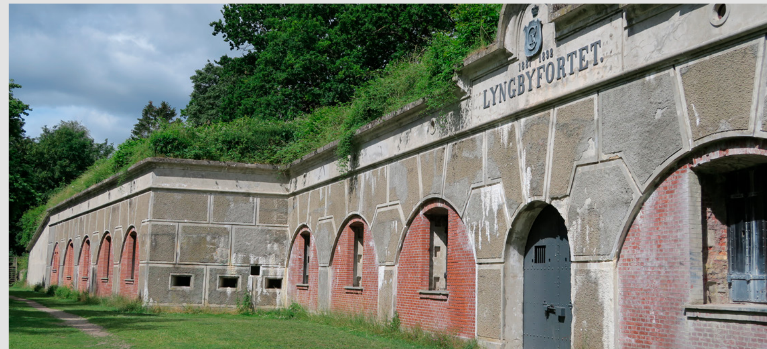
/ Lyngbyfortet, fort kernens facade mod fortets bagside. I indhaket til venstre ses tre skydeskår. Herfra kunne man beskyde den bageste del af graven omkring fortet. Foto: Fæstningskanalens Venner
