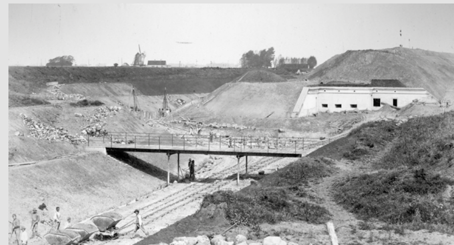
/ Vestvolden i Brøndby under byggeriet, 1890. Bygningen til højre er en næsten færdig kaponiere. Kaponiererne er solide betonstillinger, hvorfra man kunne forsvare voldgraven.
