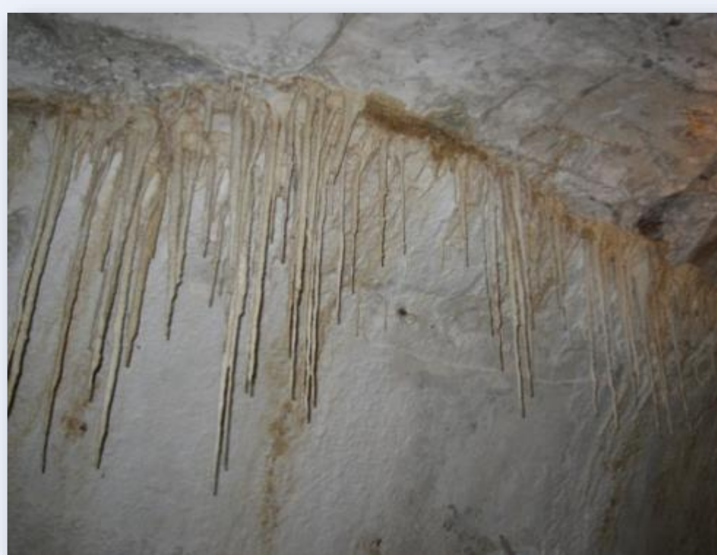
Grov revne i betonkonstruktionen
