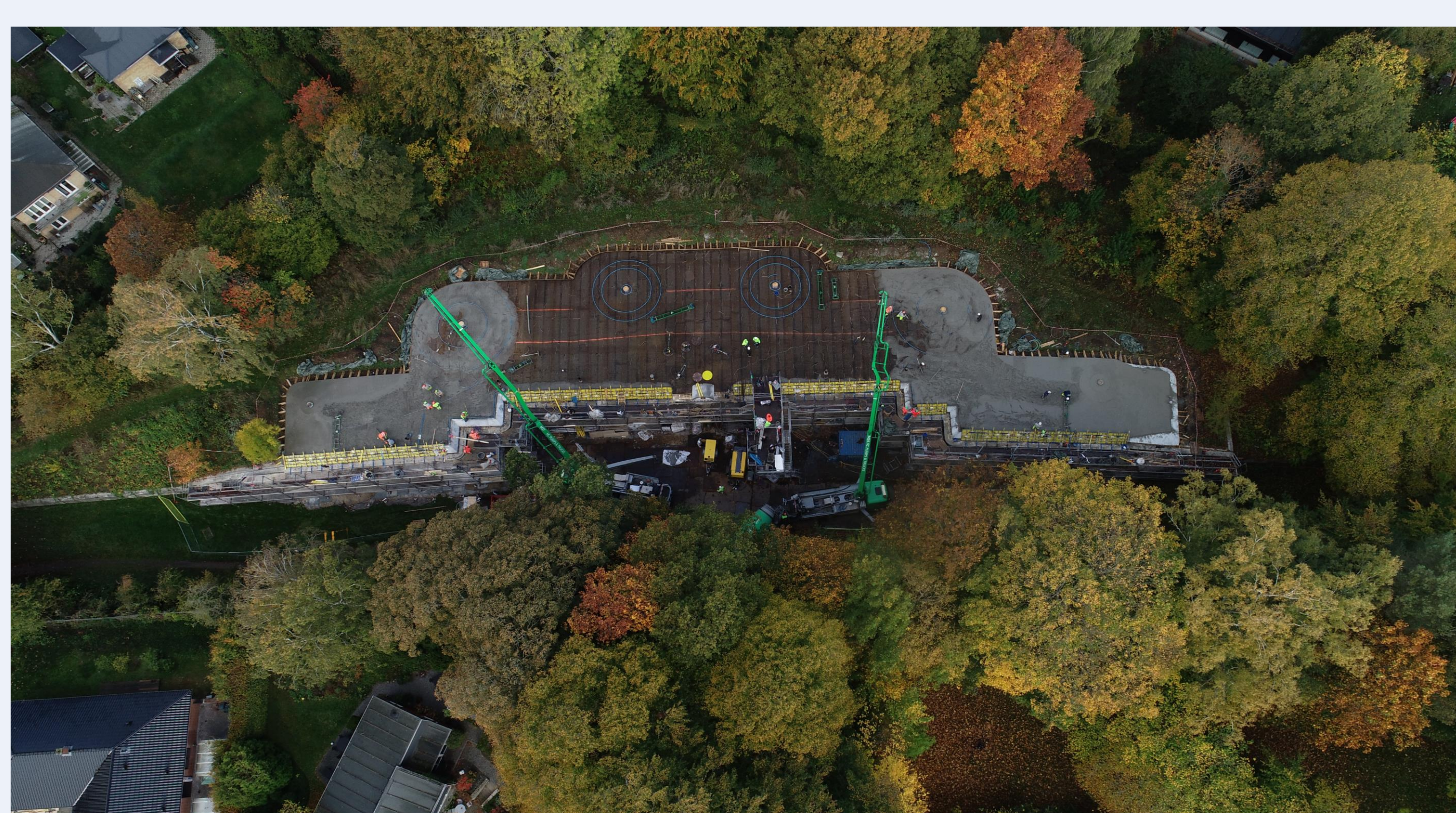
Dronefoto af støbearbejderne på fortets tag. Kun den midterste del af taget mangler at blive støbt. Der var tilkørt to betonpumper, en til hver side af fortet, så støbningen kunne foregå kontinuerligt i løbet af dagen. Dronefoto: COWI A/S
