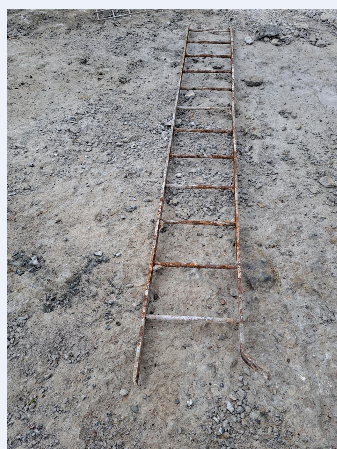
Støbejernsstige fra et observationstårn, der var indstøbt som armering i et kanontårn
