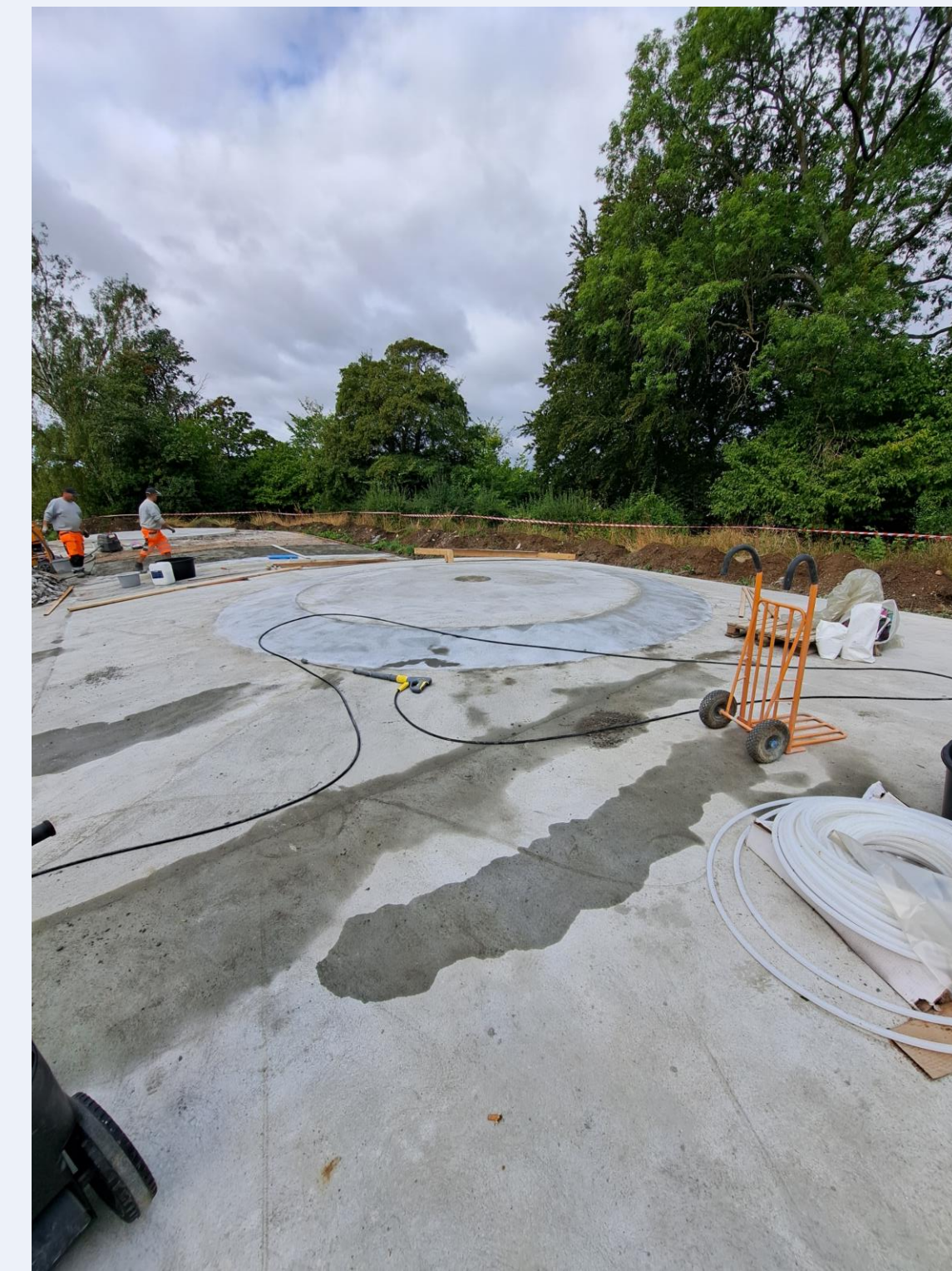
Tagoverfladen med afretningslag og et færdigstøbt kanontårn
