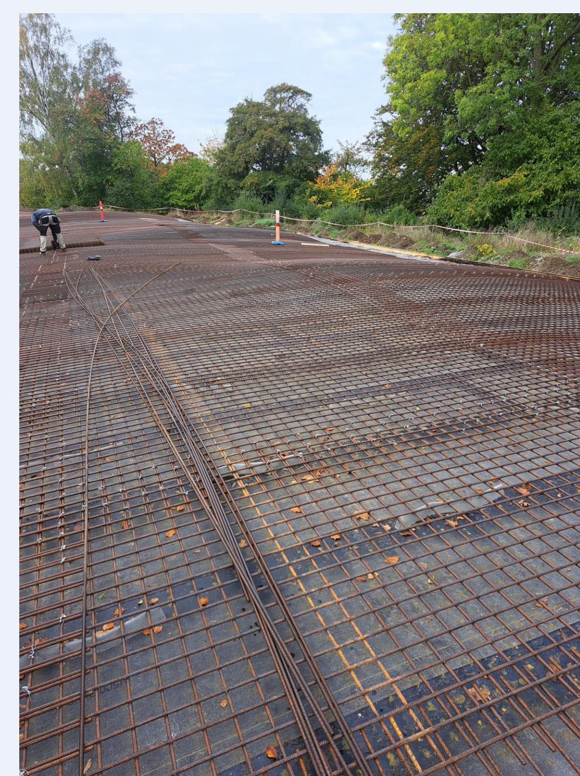
Tagoverfladen med tagpap og armeringsjern er klar til støbning
