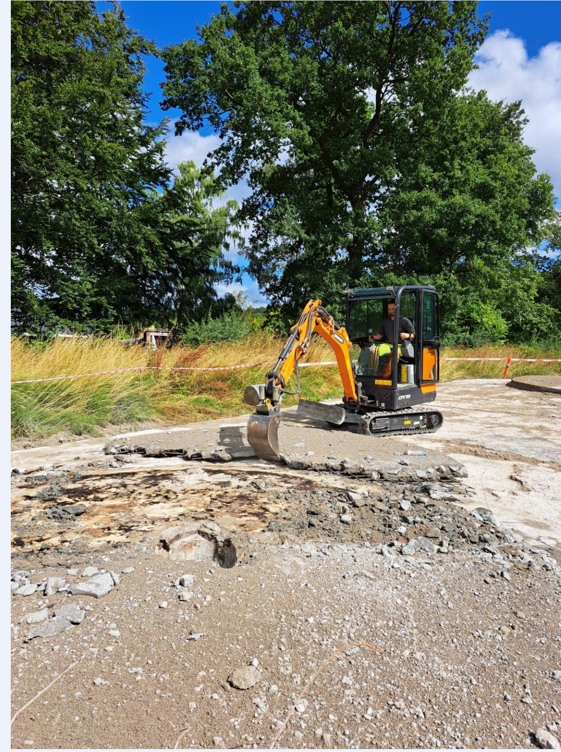
Nedrivning af øverste betonlag på et kanontårn
