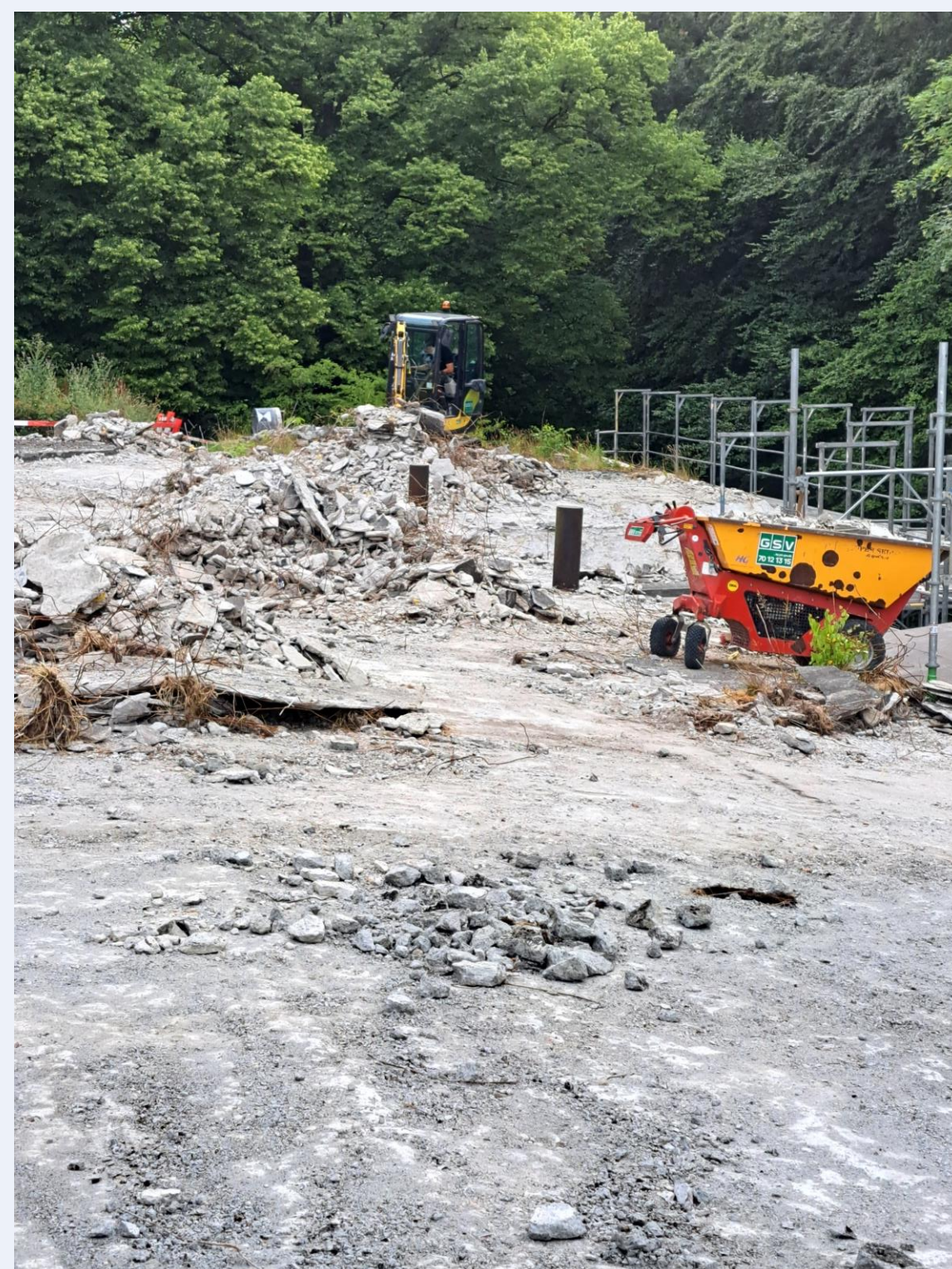
Nedrivning af den gamle beskyttelsesbeton
