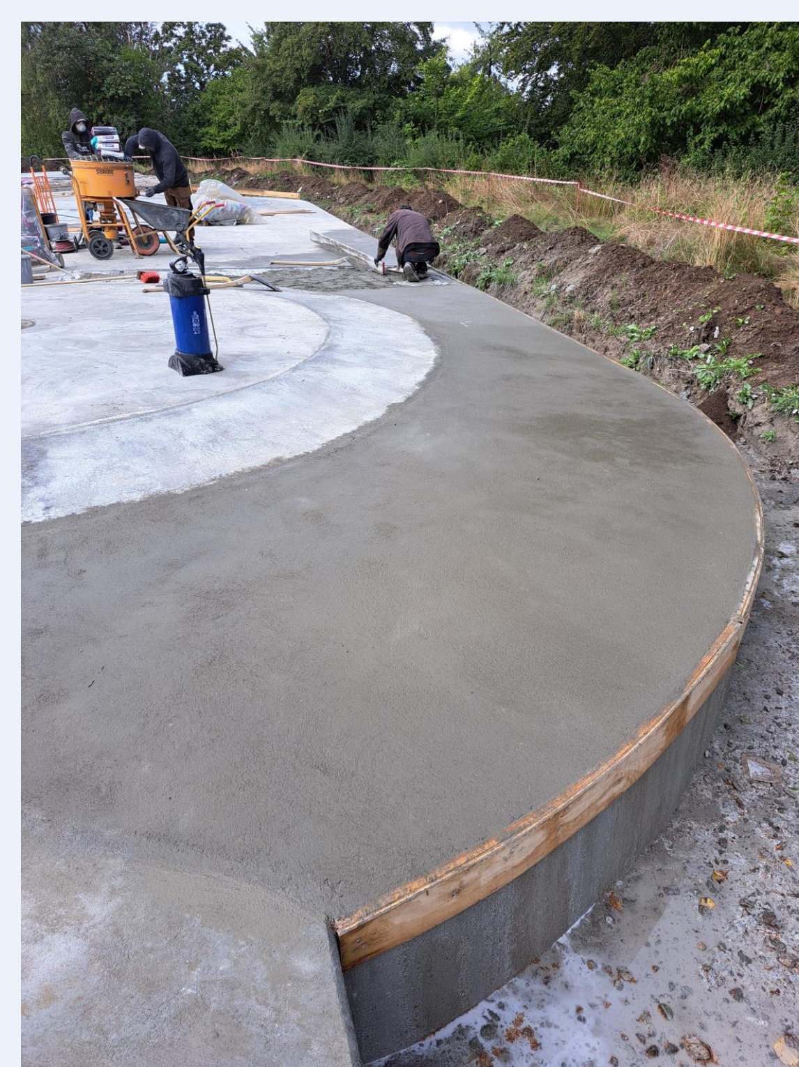
Støbning af afretningslaget på tagoverfladen udføres i mindre sektioner
