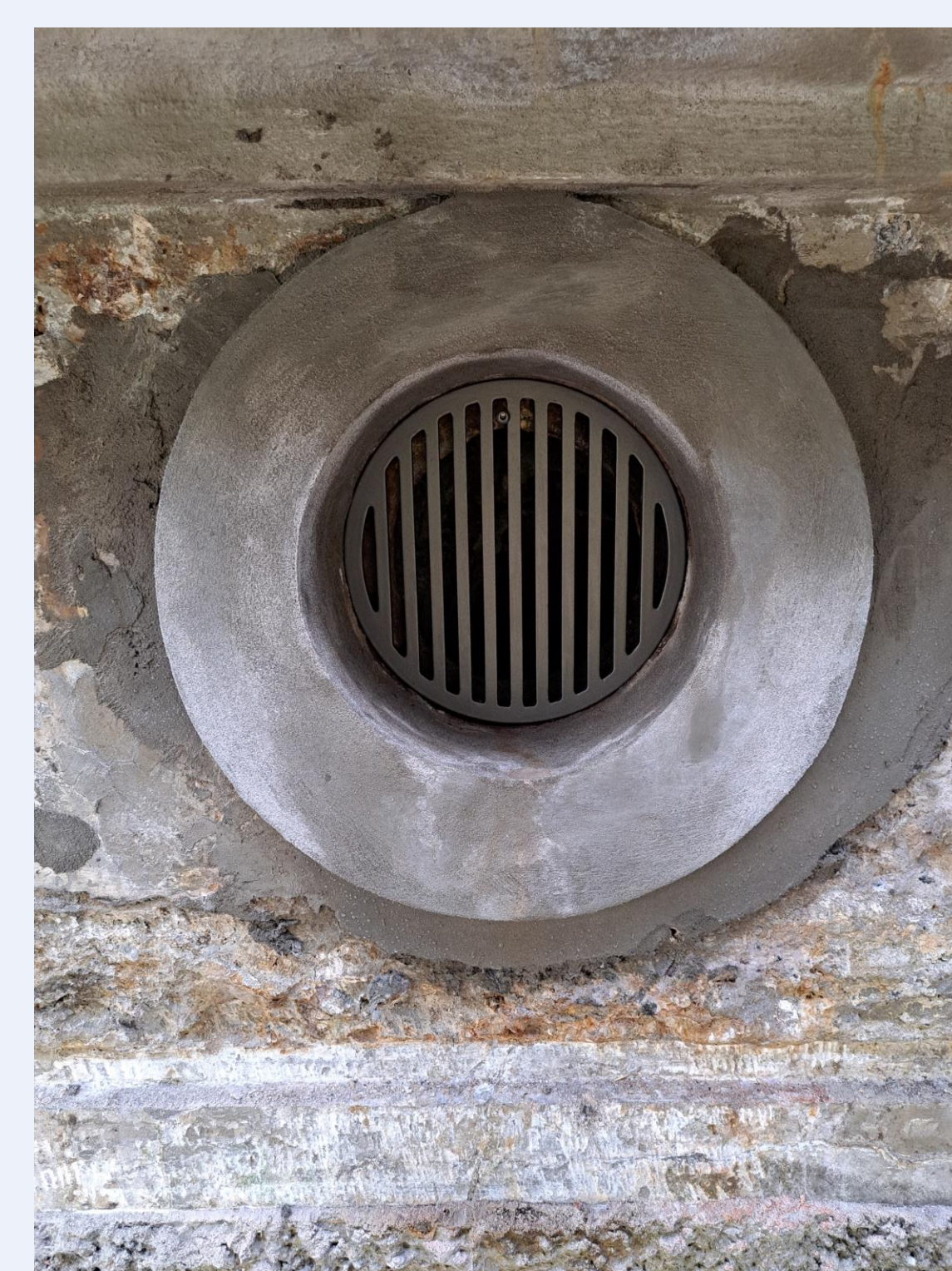
Åbning til ventilationskanal med nystøbt krans og nyt smedejernsgitter
