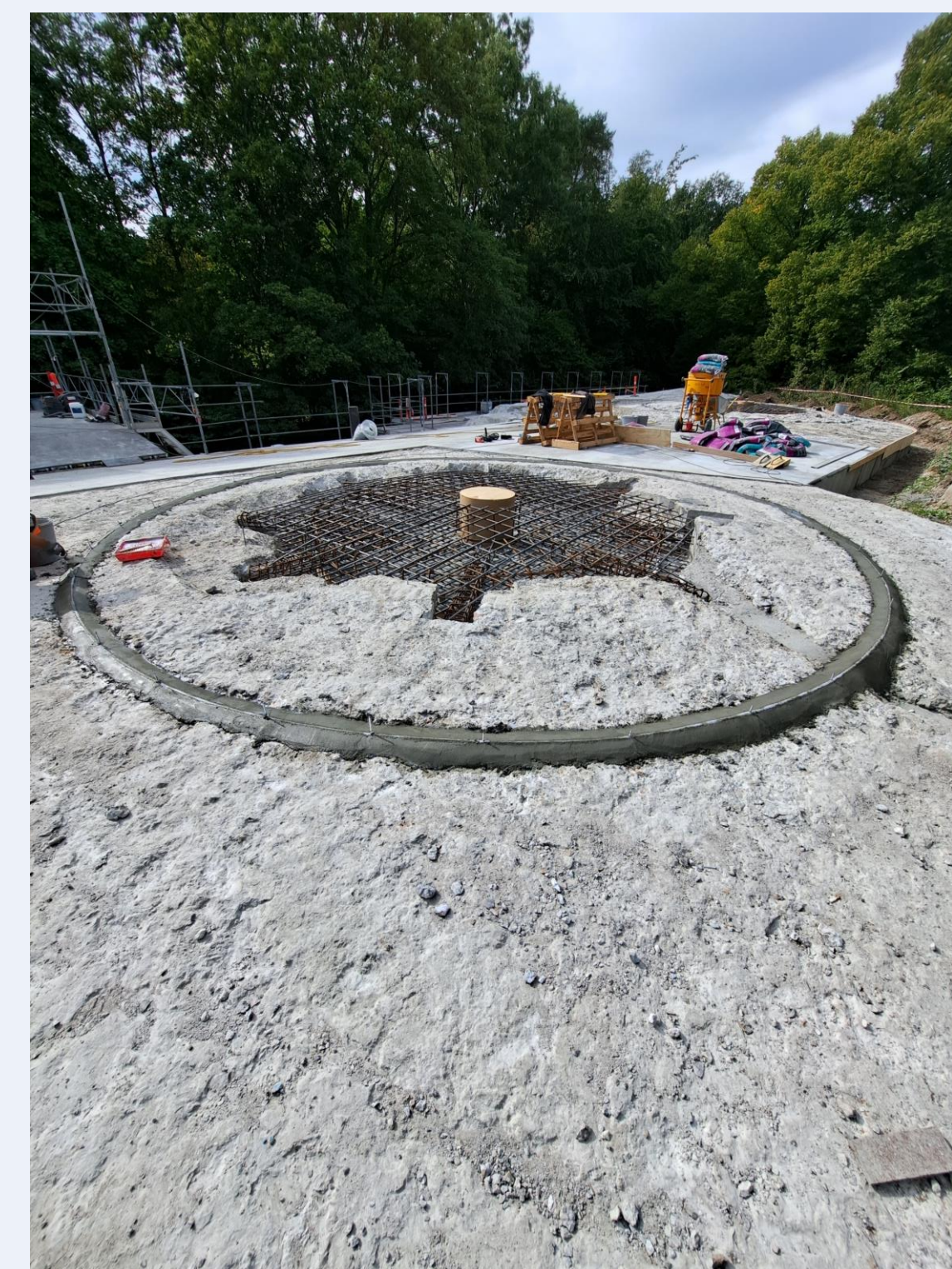
Kanontårn klargjort til støbning med armeringsjern og forskalling til ventilationshul i midten af tårnet
