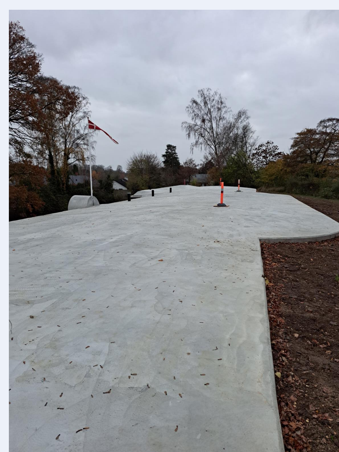
Den færdigstøbte tagoverflade
