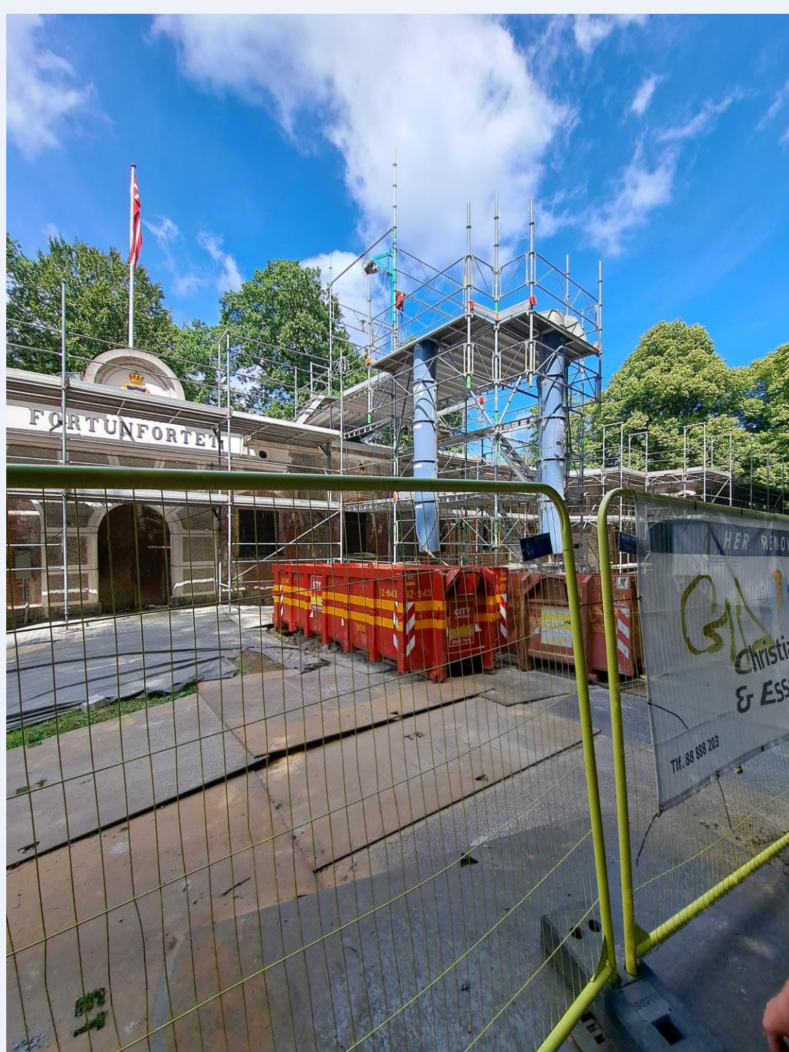
Stilladset er sat op og byggepladshegnet er på plads
