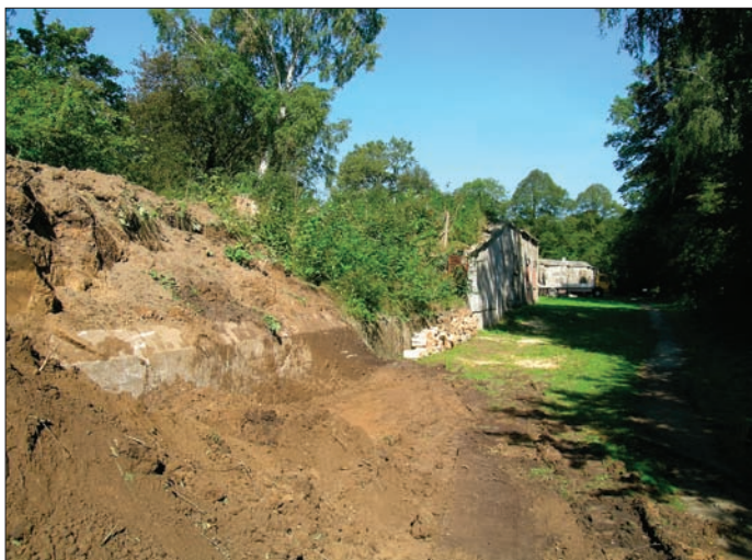
Foto 1295e1-2. Bortgravning af escapemuren.
