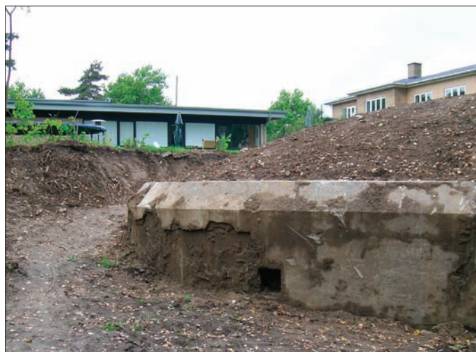
Foto 1295e5-4. Den vestlige escapemur og strube-grav. Skakthullet ses i muren, set fra syd.
