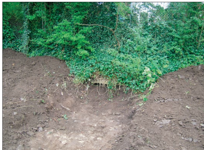
Foto 1295e6-1. "Beton"-porten i strubegravens sydvestlige skråning, set fra nord.
