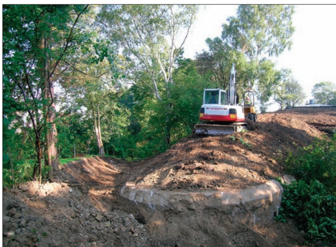
Foto 1295e7-5. Niels Otte frilægger område foran den vestlige escapemur
