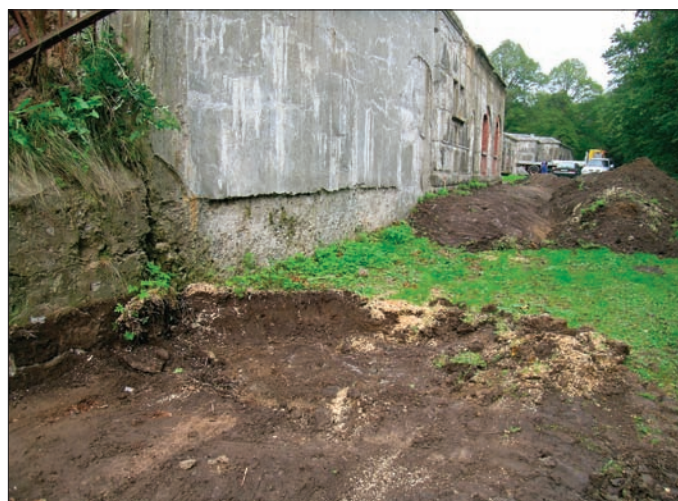
Foto 1295e2-4. Stenfaskinen stopper ved escapemuren
