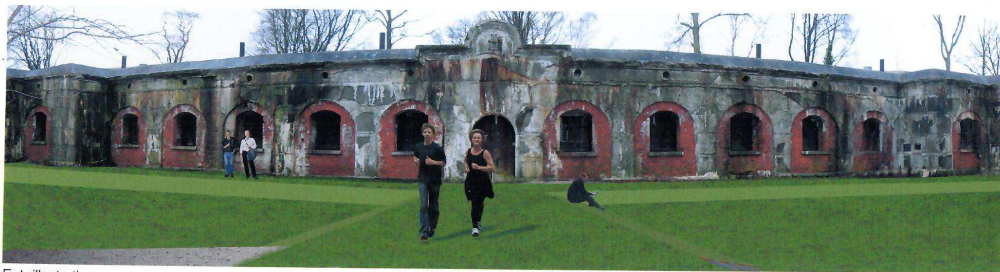
Fotoillustration Terrænregulering i strubegraven og adgangsvej foran fortet
